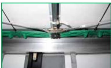
Dachaussteifung Roof reinforcement
